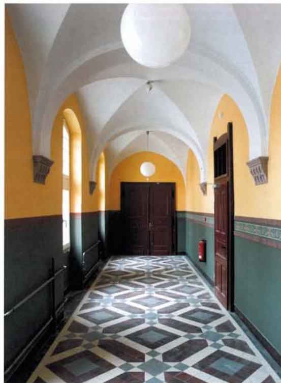
Abb. 6: Flurzone 2. Obergeschoss im Vorzustand mit Fassung von 1962
