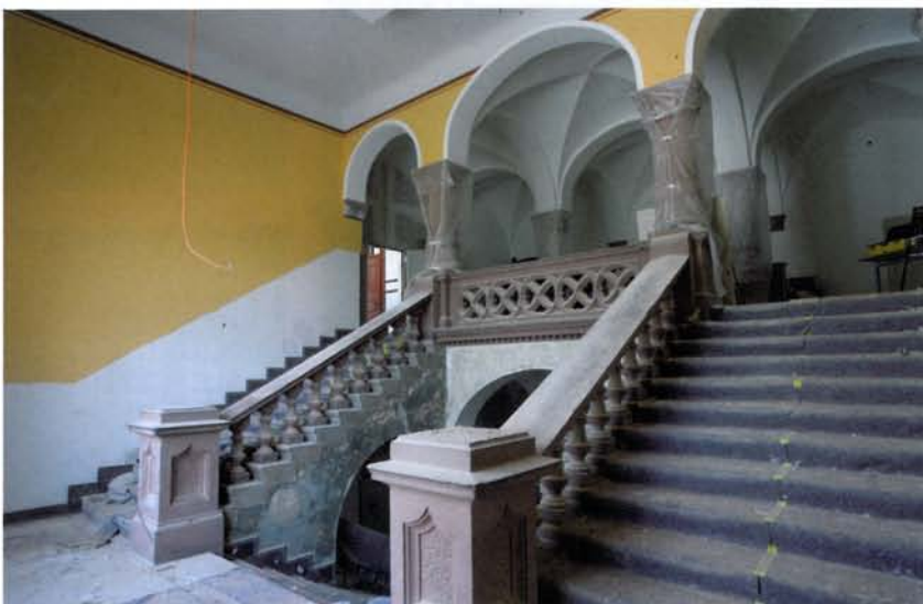
Abb. 20: Treppenhäus während der Restaurierung
